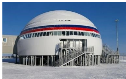
Рисунок 1. Слева: Антарктическая станция принцессы Елизаветы, управляемая Бельгией. Справа: "Арктический трилистник", образец свайного фундамента и опор над землей
