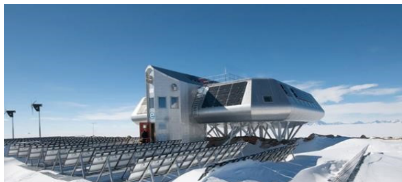
Рисунок 1. Слева: Антарктическая станция принцессы Елизаветы, управляемая Бельгией. Справа: "Арктический трилистник", образец свайного фундамента и опор над землей
